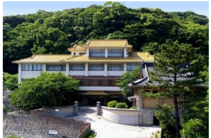
下関春帆楼本店 外観
